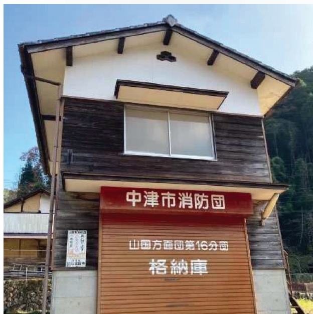
【旧 消防団詰所】
