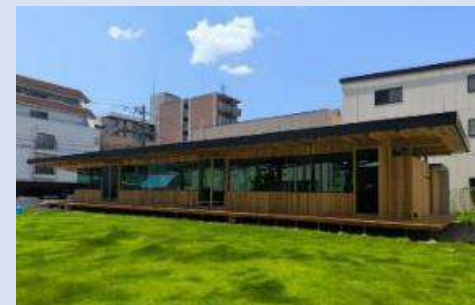
能勢産材を活用したZEB建築
