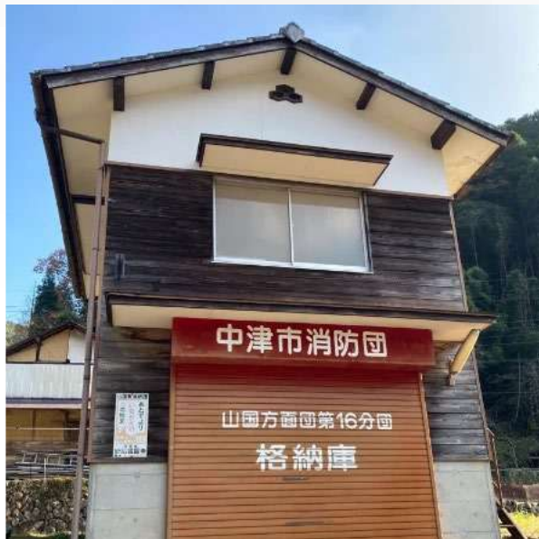
【旧 消防団詰所】
